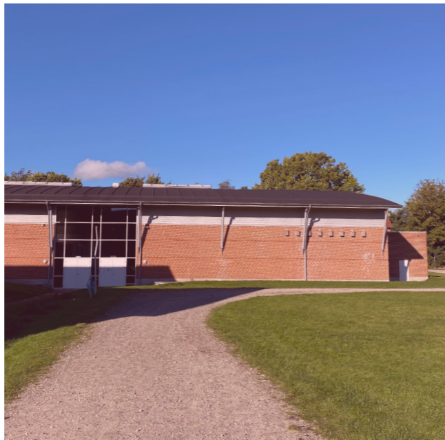
Sønderbro Kulturhus' bagside ud til sportspladsen. Potentiale for bedre udnyttelse af eksisterende faciliteter.
