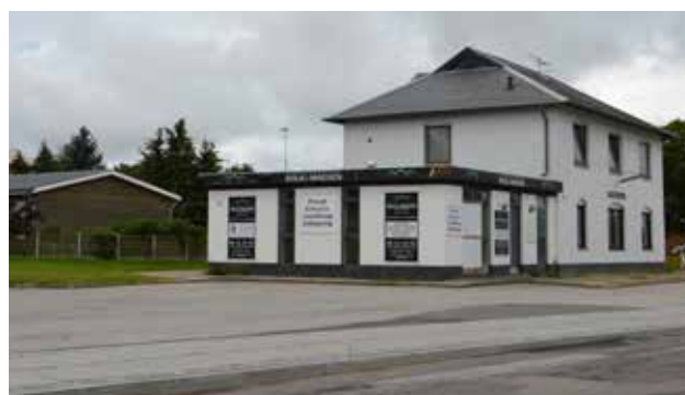
Den gamle stationsbygning med store asfalt arealer foran.
