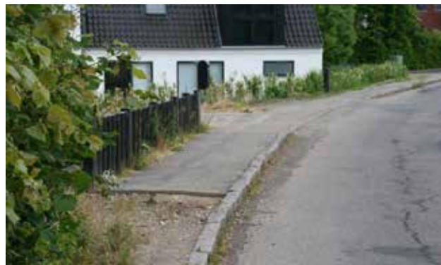
Det eksisterende fortov ved Søvej i Vestbirk.
