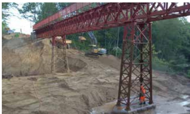
Udgravningen af den gamle jernbanebro.
