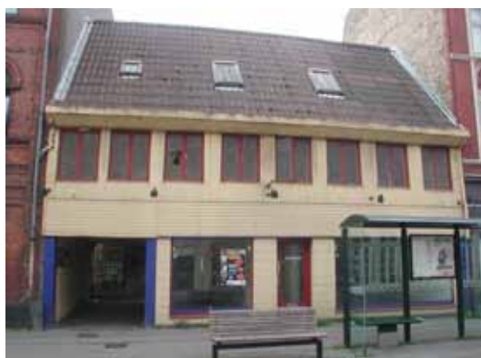
Nørregade 12 (opført 1810). Bygningen, der desværre er i forfald, gemmer sit bindingsværk bag en pladebeklædning. Den kan rives ned jf. lokalplan
