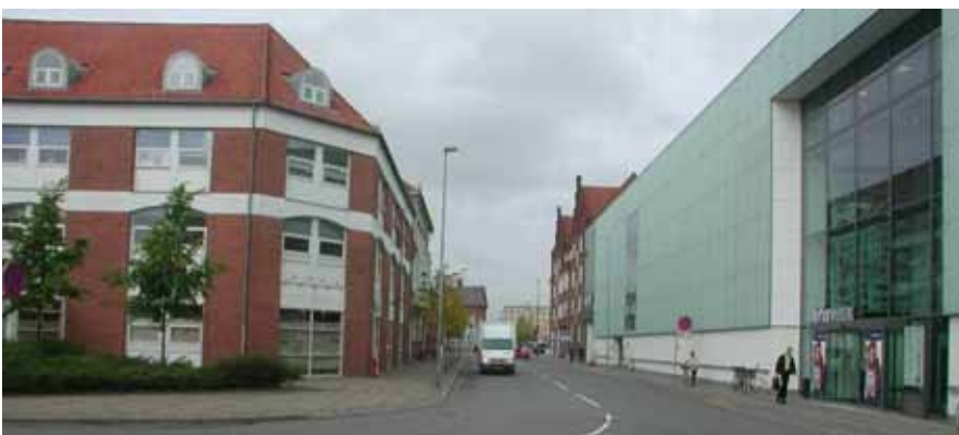
Løvenørnsgade: Det nyere byggeri til venstre overholder byens historiske vertikale skala og danner randbebyggelse. Bytorvet til højre i gaden overholder også den vertikale skala, men den næsten vinduesløse facade savner artikulation
